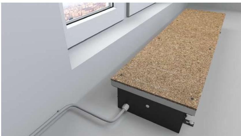
8. Залить бетоном зазоры между стенками отопительного канала и корпусом конвектора;
